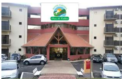
Hotel fazenda Poços de Caldas -MG
