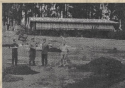
Obras das quadras externas - 1969
