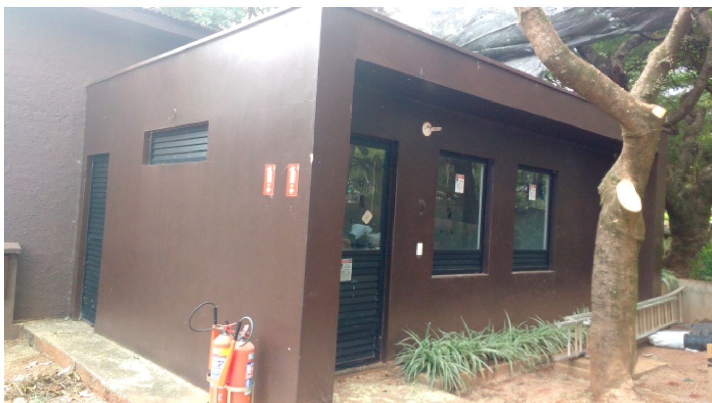
Casa de Força
