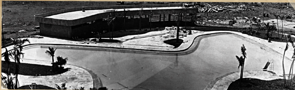
Obras Piscina Social
