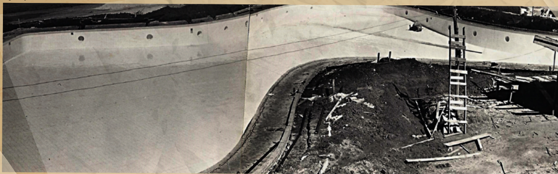
Obras Piscina Social
